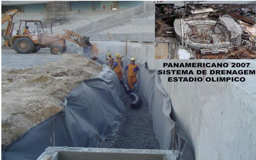
Figura 2.20 - Outra aplicação de geossintético na construção com função de drenagem, ( http://www.geomaks.com obra: PanAmericano 2007).
