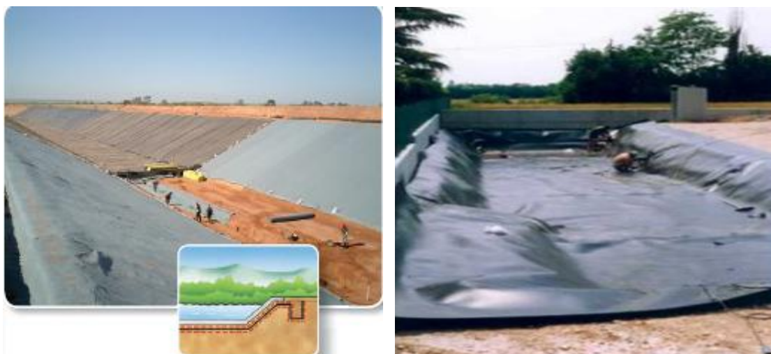
Figura 2.23 - Exemplo de aplicação de geossintéticos como barreira de fluidos ( http://mundodaimpermeabilização.blogspot.com/2009/geomembranas.html ).
