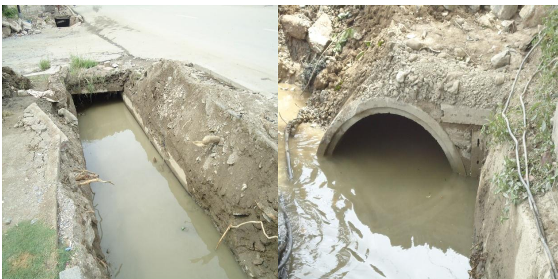
Figura 4.1 – Condições construções de drenagem em Timor Leste.
