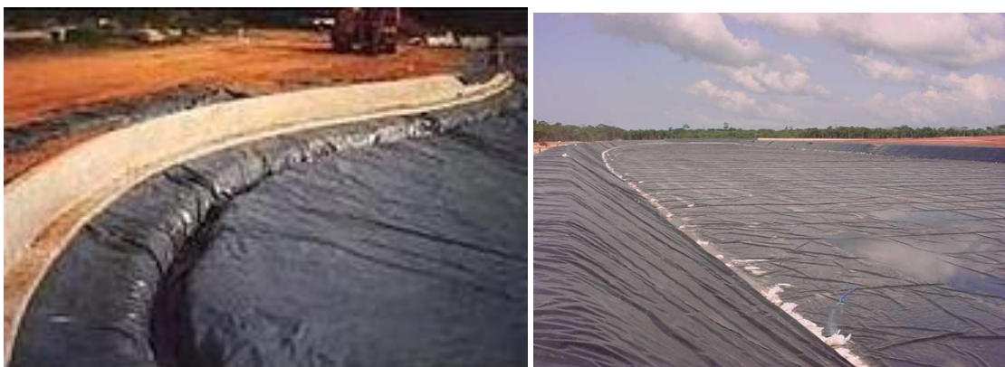
Figura 2.10 - Exemplos de aplicação de geomembrana.
