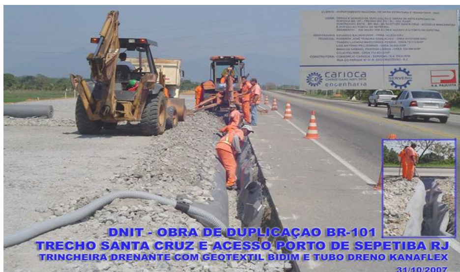
Figura 2.18 - Utilizações geossintéticos nas obras de drenagem, ( http://www.geomaks.com obra: PanAmericano 2007).
