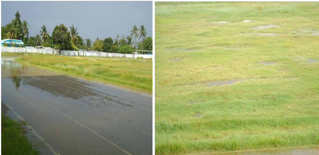
Figura 4.3 - Problemas de filtragem e drenagem no campo de futebol em Díli, Timor Leste.
