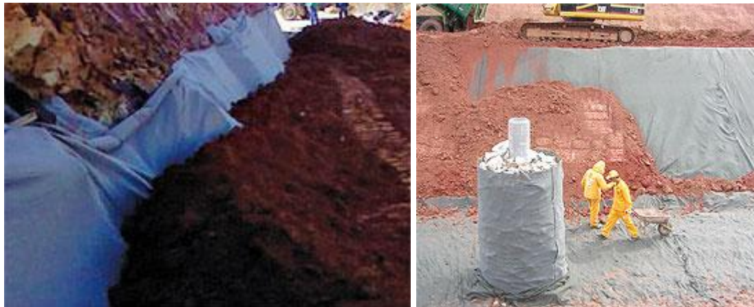
Figura 2.22 - Exemplo da aplicação de geossintéticos no controlo da erosão, ( http://www.revistatechne.com.br ).
